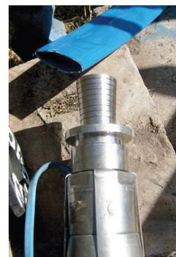
21) Faire une coupe nette perpendiculairement à l'extrémité du tuyau. Nettoyez l'extrémité du tuyau avec de l'eau et séchez-la avec un chiffon.
