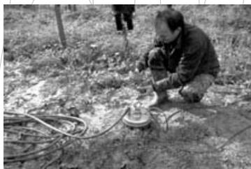
stade, les vis de serrage du collier doivent être resserrées. Enfin, placez le couvercle du puits sur le bord du puits et passez le câble dans la fente réalisée au préalable.
