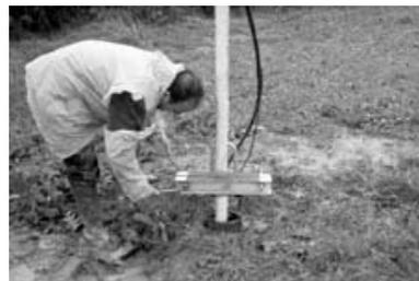
16) Lorsque la distance entre les tuyaux Rylbrun est déjà inférieure à  $L$ , fixez le raccord de borne supérieur avec le couvercle de trou d'homme. Fixez un crochet ou similaire au fil supérieur du couvercle pour le fixer au câble de la grue.
