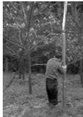
10) Soulevez le tuyau avec la grue. Celui-ci montera jusqu'à ce que la pompe soit complètement perpendiculaire à l'entrée du puits. Étant suspendue la pompe, serrer les vis de tension de l'accessoire conique amovible en acier inoxydable afin de déplacer la pince vers la partie large de l'arbre de montage.
